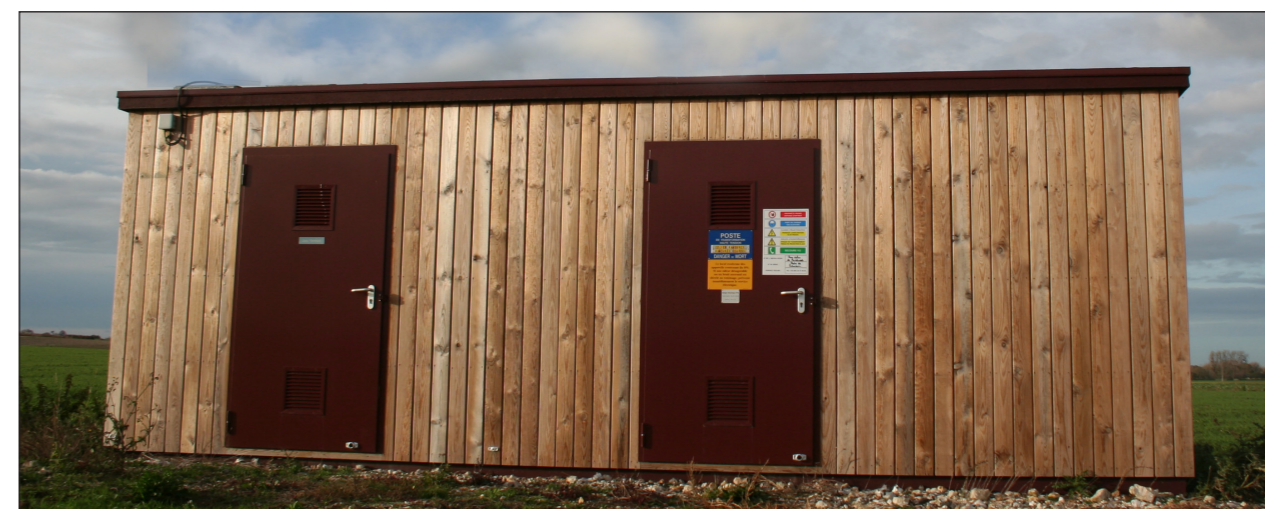
Exemple-type de poste de livraison
